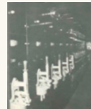
旧最高裁判所の配電盤
